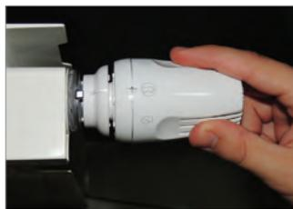
**4)** À ce stade, la tête est fixée au robinet et peut être placée dans la position de réglage souhaitée en tournant le volant.
