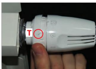
2) Tourner la bague limitative et la raccrocher, en prenant comme repère l'encoche indicatrice "T" (voir figure), au niveau d'une des 3 icônes présentes à l'arrière du volant :
