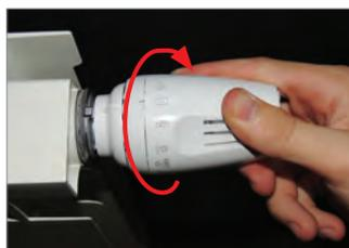
**3)** Fermer à fond la tête en tournant le volant (mettre le volant en position "0").
