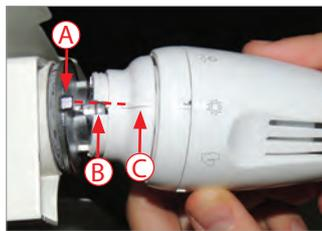
**2)** Accrocher la tête thermostatique au robinet en vérifiant que le goujon du robinet (A), la fente de la tête thermostatique (B), l'encoche indicatrice de la bague Clip-Clap (C), sont alignés.
