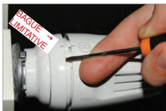
1) Tourner le volant dans la position que l'on souhaite bloquer/partialiser et décrocher la bague de limitation, en s'aidant d'un tournevis.
